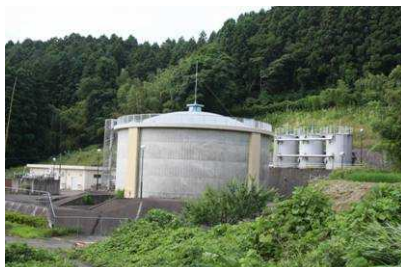
滝ノ入浄水場
