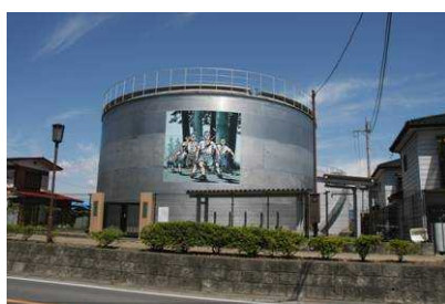
並木副配水池
